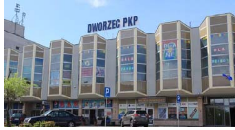
Rysunek 3.8. Dworzec kolejowy kat. B w Słupsku
