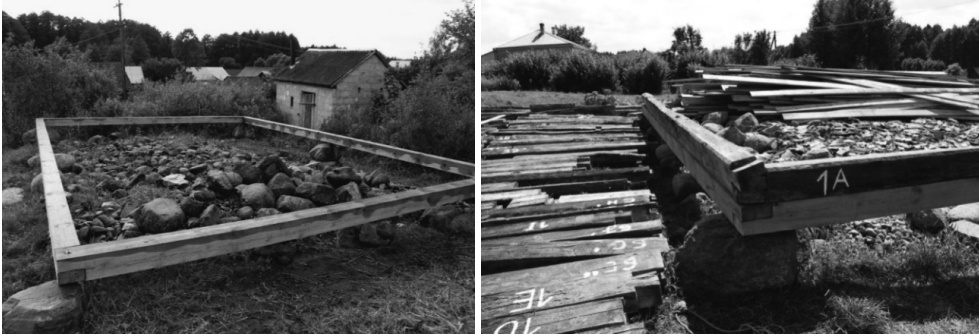
Fotografia 4. Jeden z początkowych etapów budowy gospodarstwa agroturystycznego Źródło: fotografie Michała Romana.
