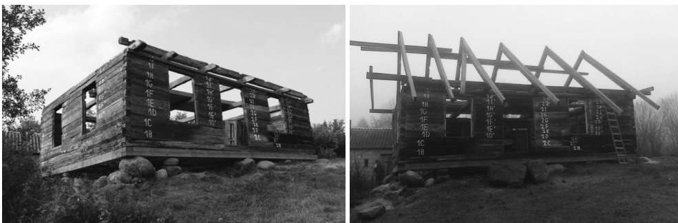
Fotografia 5. Jeden z początkowych etapów budowy gospodarstwa agroturystycznego Źródło: fotografie Michała Romana.
