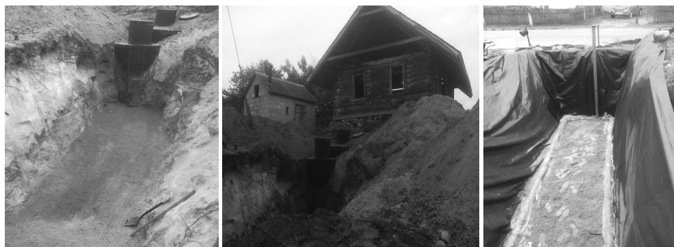
Fotografia 1. Etapy budowy przydomowej ekologicznej oczyszczalni ścieków
